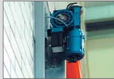
Antriebsanordnung wahlweise rechts oder links
