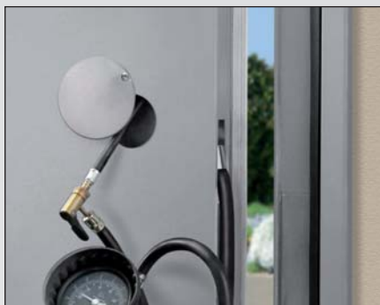
Ansetzen des Kompressors zum Aufpumpen der 3-seitigen Schlauchdichtung.
