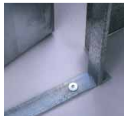
Flachstahl mit Bodenbefestigung
