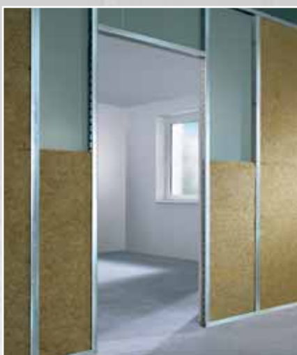
Einsatz der Dämmplatten in die Montagewand.
