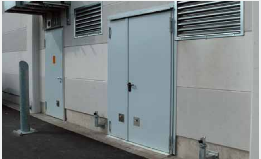
dw 67-1/HS bis 57 dB und dw 67-2/HS bis 55 dB, zur Schalldämmung von Klimaanlage
