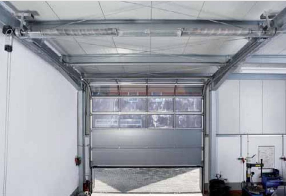
Hat die Halle eine extreme Höhe oder darf der Betrieb innerhalb der Halle vor dem Tor nicht gestört werden, wird die Torführung den örtlichen Gegebenheiten angepasst. So können z.B. Kranbahnen durch höhergeführte Laufschienen mit einer 90°-Umlenkung umgangen werden. Für die Teckentrup Sectionaltore stehen viele Beschlagvarianten zur Verfügung.
