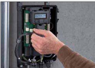
Die Steuerungen werden werkseitig steckerfertig vorverdrahtet.
