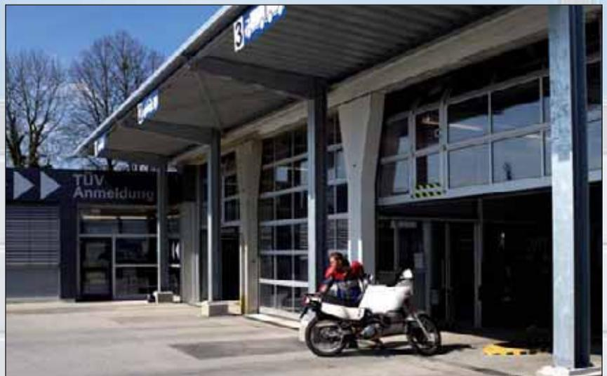
Sectionaltor SL mit verglaster Bodensection.
