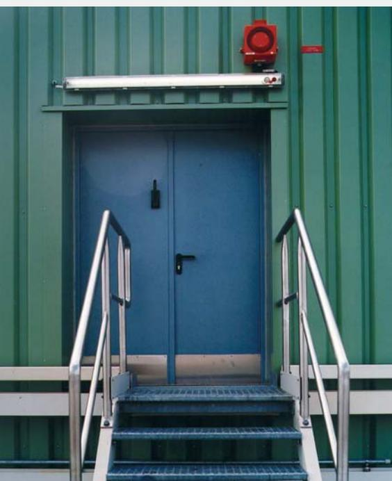
dw 42-2 „Teckentrup“ mit Stoßplatten im Bodenbereich.
