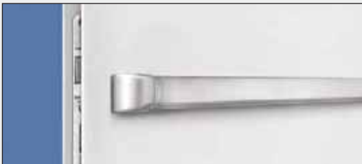
Panik-Druckstange (Pushbar): Öffnet die Tür nur durch leichten Druck von innen.
