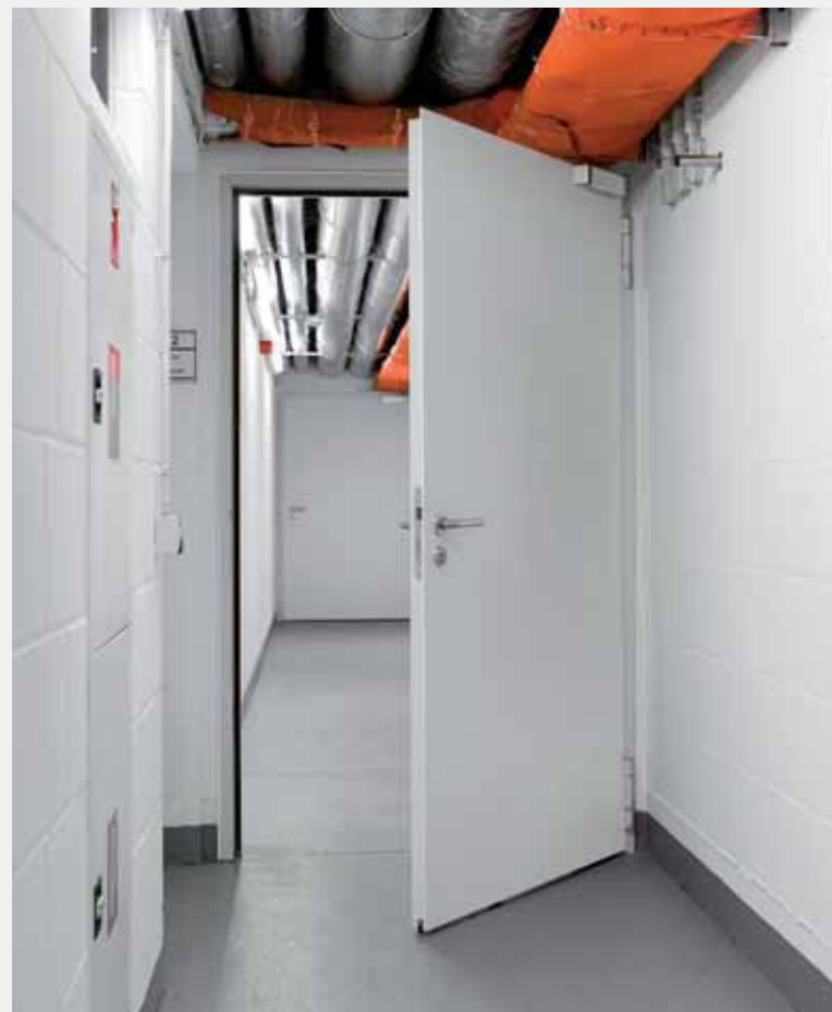
Feuerhemmende Stahltür T30-1-FSA „Teckentrup 42“, rauchdicht
