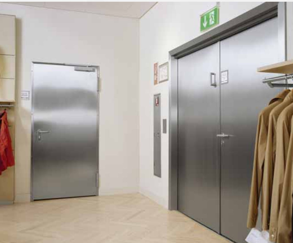
Feuerschutztüren, 1- und 2-flügelig, in einem Modehaus.
