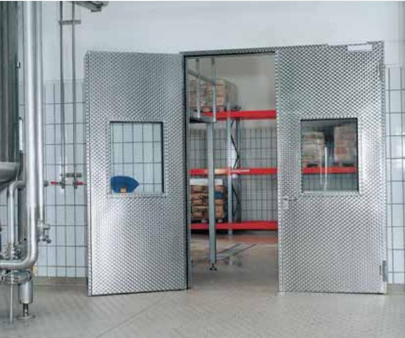
Feuerschutztür, 2-flügelig, marmorierte Oberfläche, in einem Brauereibetrieb.
